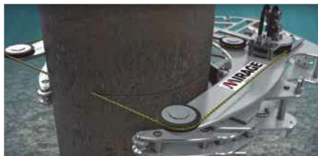
▼ Découpe de piliers sous l'eau.
